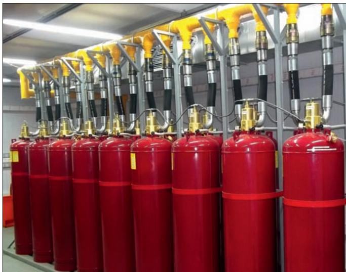
Модульная установка газового пожаротушения с применением GOTV Novac 1230
